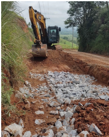
Obras seguem a todo vapor...
