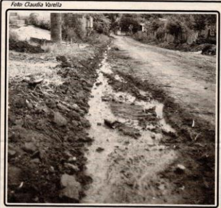
ESGOTO - A Sabesp retomou segunda-feira, dia 10, as obras de canalização da rede de esgoto na rua Odília Godoy, no bairro do Quilombo. A obra ficou paralisada por algumas semanas porque a Sabesp dependia da liberação de uma retroescavadeira, o que foi conseguido da Prefeitura na semana passada.
