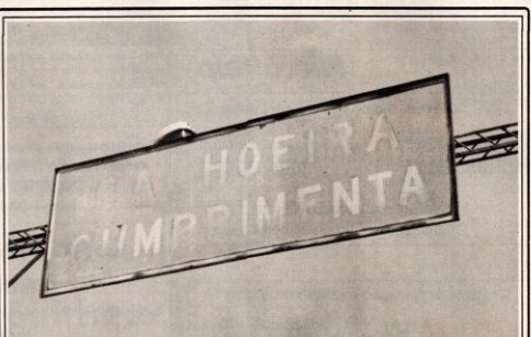
REPINTURA URGENTE - A placa localizada na entrada da cidade precisa de uma pintura urgente, pois as letras da frase estão desaparecendo, descoradas pelo tempo.
