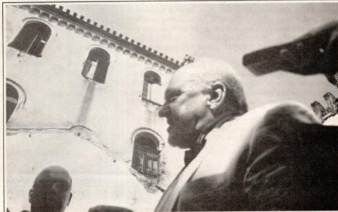
Massarani, que conheceu a Estação em 1953, ficou impressionado com o estado de abandono do prédio
