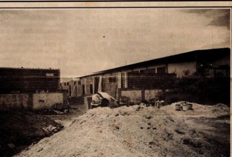
ESCOLA - A Prefeitura está ampliando a Escola Professor Otton Fernandes Barbosa, de educação infantil (níveis 1, 2 e 3) e ensino fundamental (1ª a 4ª séries) no Jardim Trabalhista, com a construção de oito salas e seis sanitários.
