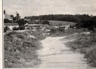
Entulho amontado nas margens do córrego estreita rua do loteamento
