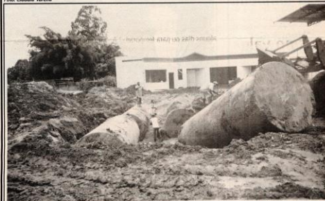
Trabalhadores fazem a colocação de quatro tanques de combustível no Autoposto Dona Isabel, que deverá ser inaugurado no próximo dia 20 de janeiro. Cada tanque tem capacidade de 15 mil litros de combustível.
