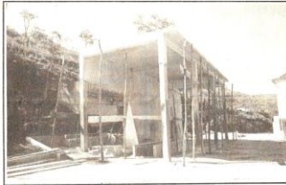
Fonte de água benta, em construção, terá seis bicas para os fiéis
