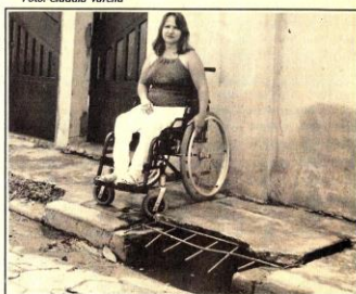
Aparecida mostra bueiro quebrado e entupido em frente a sua casa
