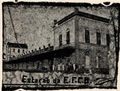
CACHOEIRA — Estação da E. F. C. B.
